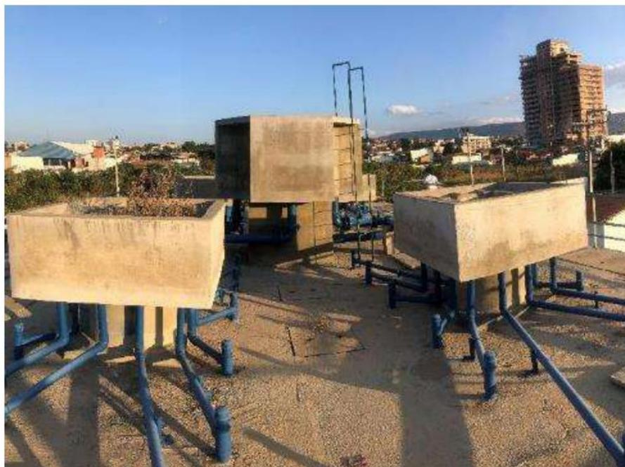
FIGURA 48. CAIXA DE DISTRIBUIÇÃO DE VAZÃO.
