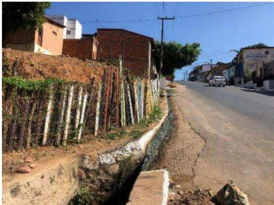
FIGURA 14. PC-04 - LANÇAMENTO DE ESGOTO A CÉU ABERTO.
