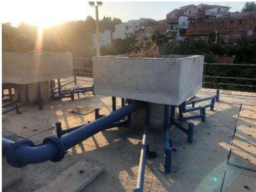
FIGURA 49. CAIXA DE DISTRIBUIÇÃO DE VAZÃO.
